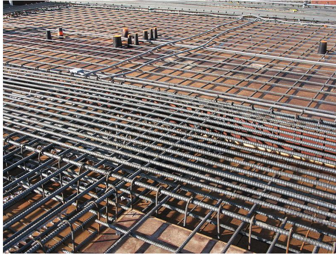
Obr. 2 Výztuha betonové konstrukce
